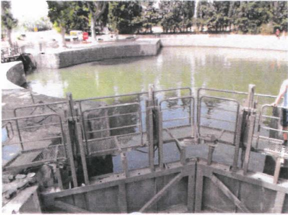
L'écluse ronde est comme un rond point, elle permet de rejoindre la mer avec le fleuve Hérault, de remonter sur le canal du midi ou sur le fleuve Hérault. Elle a trois portes qui s'ouvrent grâce à des moteurs qui actionnent des vérins.
